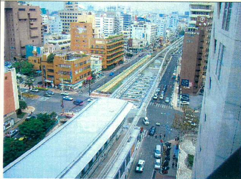
モノレール軌道俯瞰図1 （県庁前駅付近）
