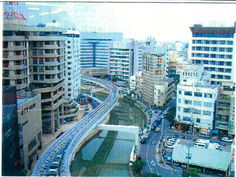
モノレール軌道俯瞰図2 （県庁前駅付近）
